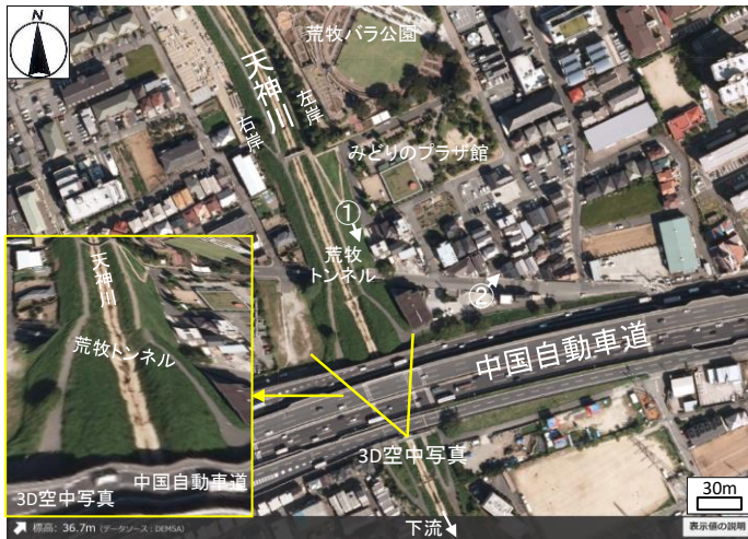
写真1 被災地周辺の空中写真(地理院地図より転載)。①②は写真3の撮影地点、矢印は撮影方向
