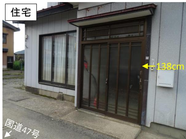
写真3 古口地区における住宅の浸水被害
