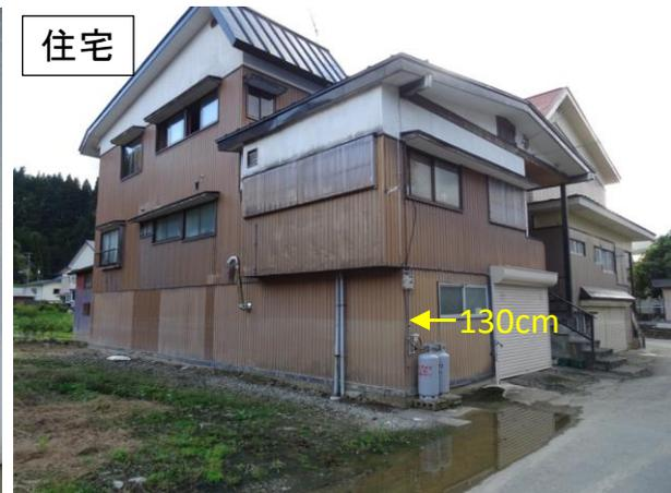
写真4 古口地区における住宅の浸水被害
