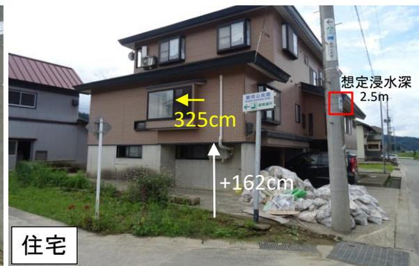
写真2 蔵岡地区における住宅の浸水被害
