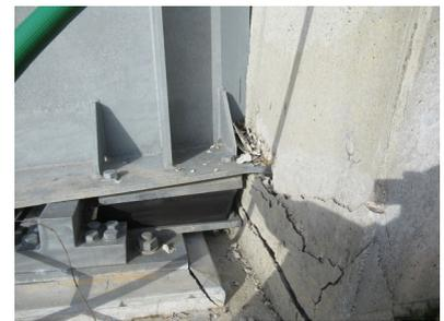
(c) 主桁下フランジの座屈(A2側)
