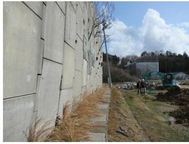
(b) 壁面の前面側への孕み出し
