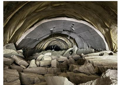
(a) 覆工コンクリートの崩落(南側から6~7スパン目、北向きに撮影)
