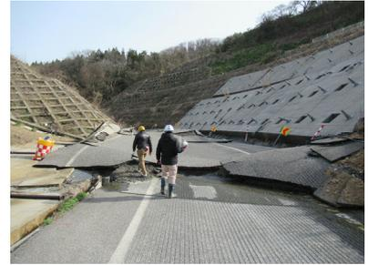
(b) 路面の変状(側方変形・隆起)
