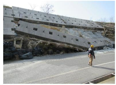
(a) 枠工の崩壊
