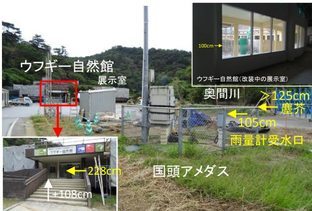
写真 3 やんばる野生生物保護センターウフギー自然館とマングースバスターズ事務所の被害
