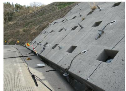
(c) グラウンドアンカーの飛び出し
