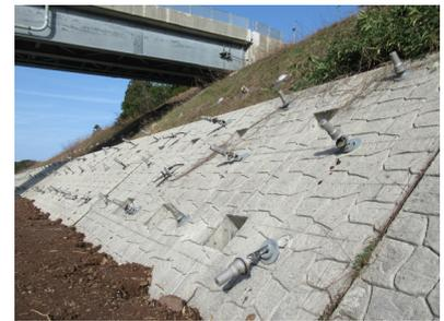
(b) グラウンドアンカーの飛び出し
