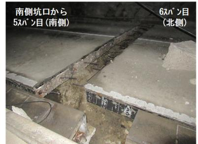
(b) コンクリート舗装の継目の変状(南側から5~6スパン目、西向きに撮影)
